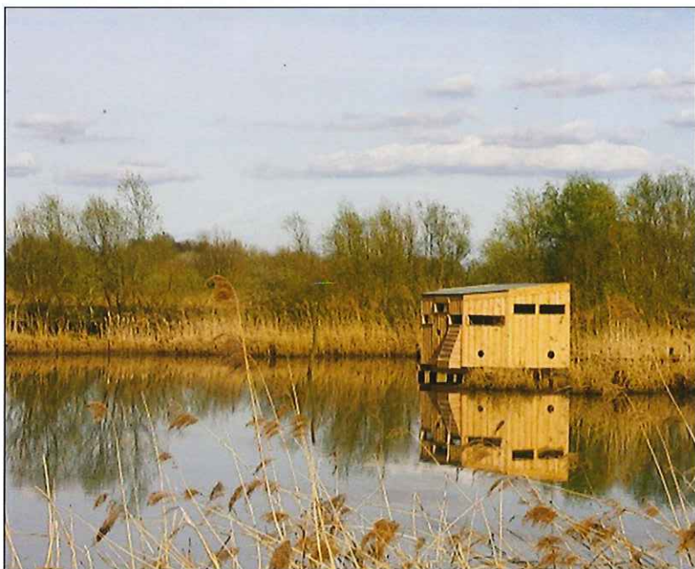
Observatoire construit en 2017 sur un des bassins « côté Darion »
